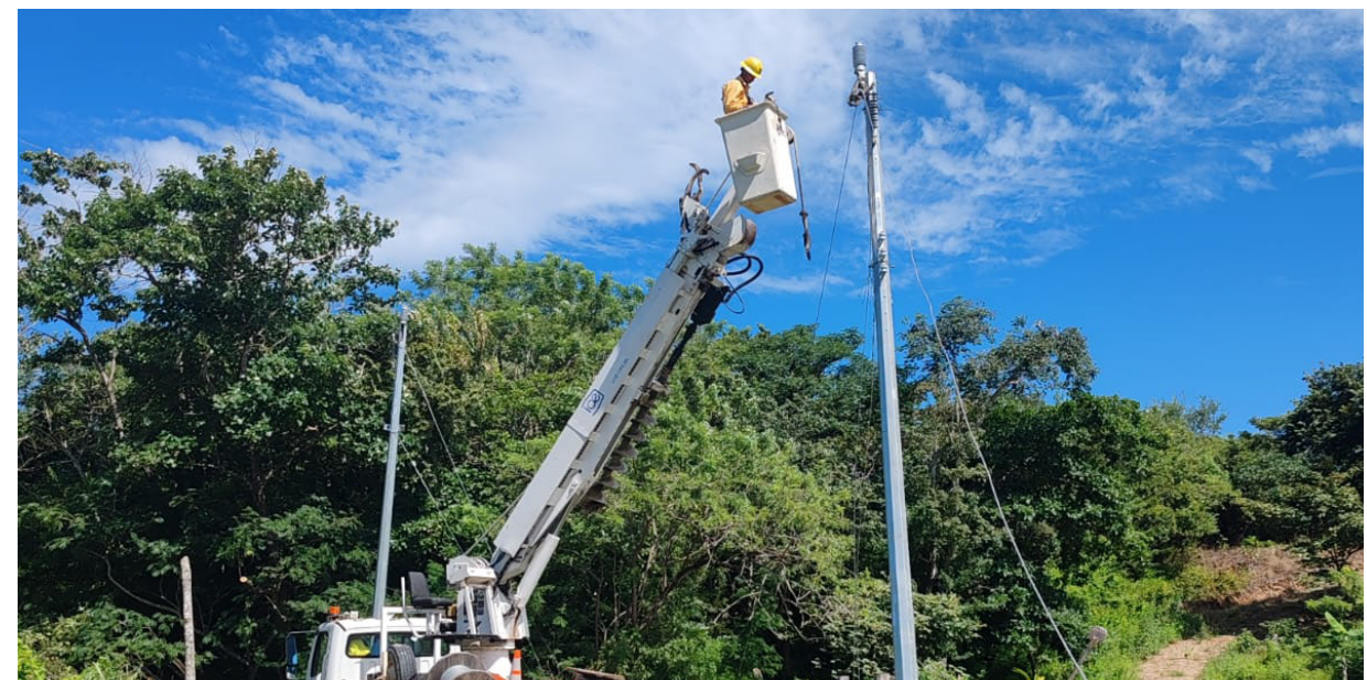
Trabajos en Colonia Bolaños, en el cantón de La Cruz.
